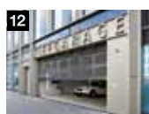
Portes de garage collectif
